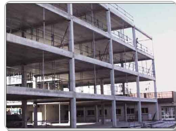
Structure poteau poutre
