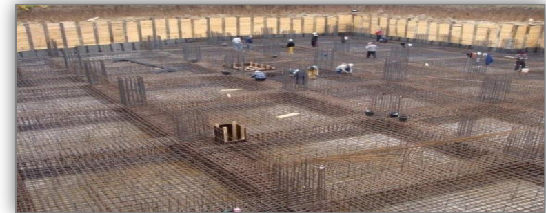
Réalisation d'un radier nervuré
