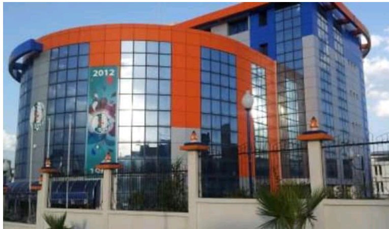
FIGURE 2.4 – Siège de la direction centrale de Sonelgaz
