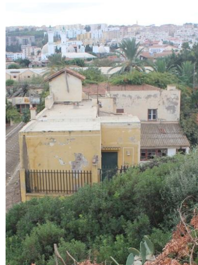
Vue sur l'accès secondaire
