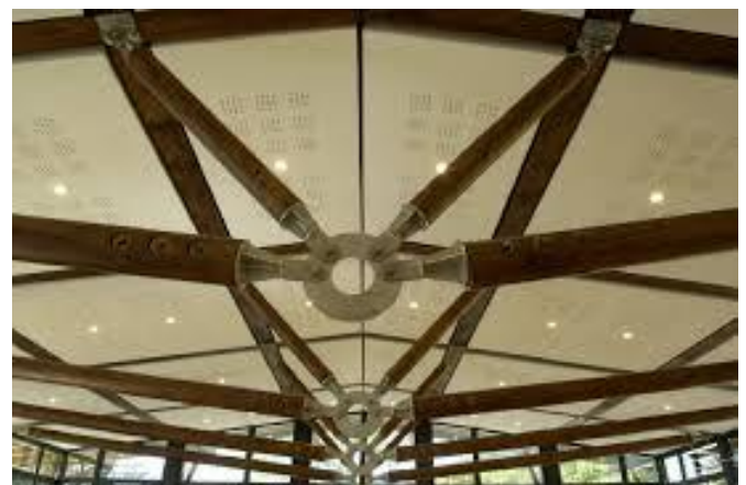
65444432Détail de la charpente de
