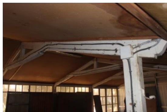
Intérieur de la toiture
