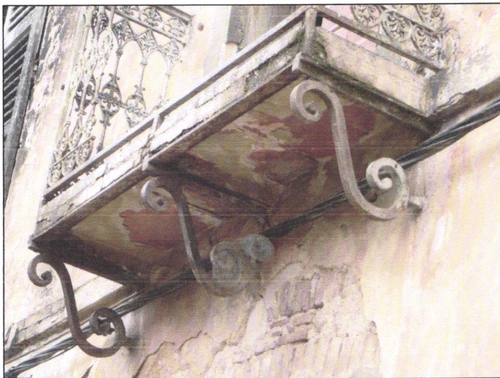
Rue Bouarba Hamid - îlot 09
