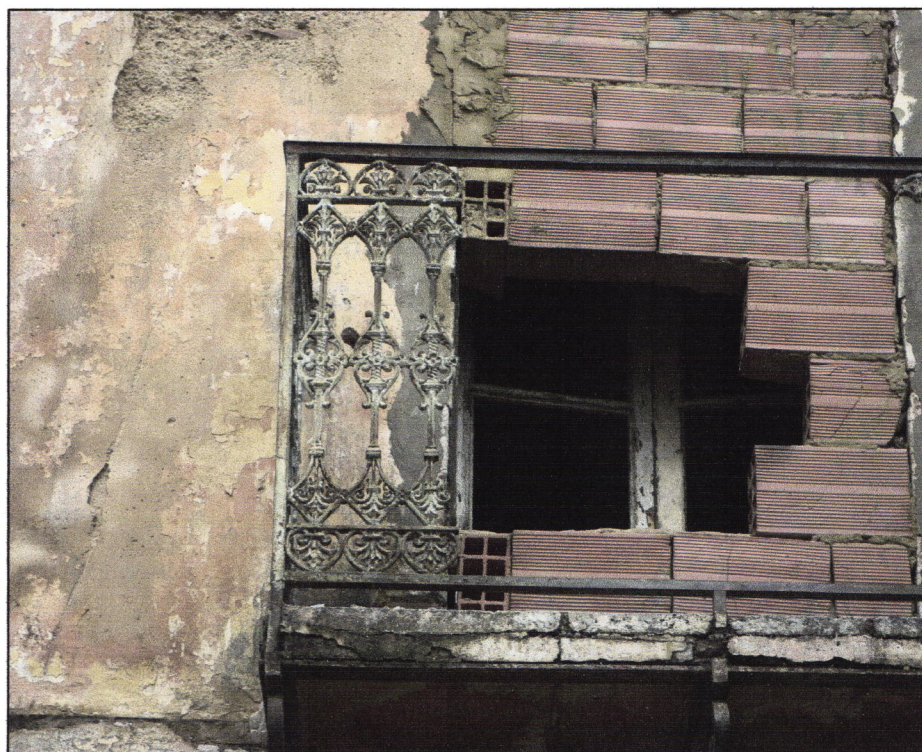
Rue Bouarba Hamid - îlot 09
