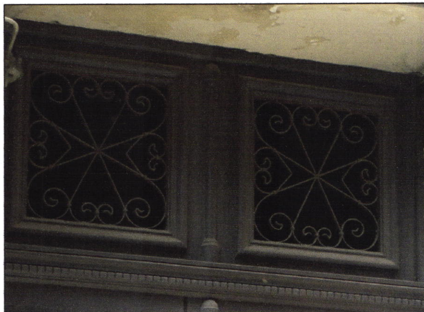
Rue Bouarba Hamid - îlot 09
