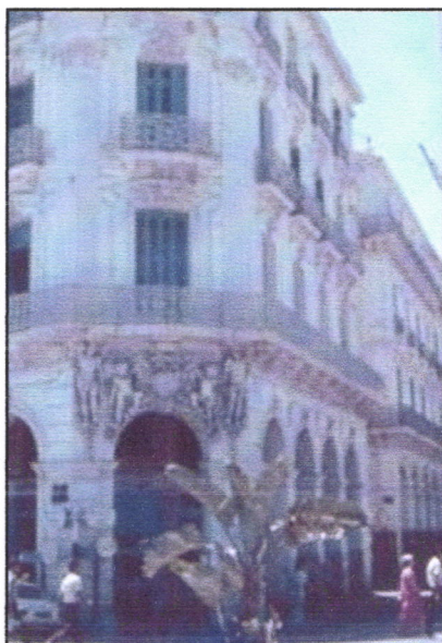
Fig. 11. Immeuble urbain de la fin du XIX e siècle Architecture "classicisante", Alger. Source : web
