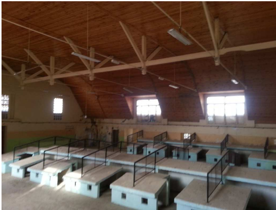
photo 9 vue su l'intérieur montrant les elements en beton arméet le faux plafond en bois
