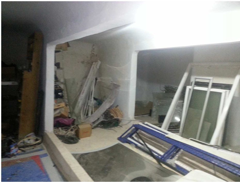
photo 10 percement et regroupement des cuves au nombre de trois utilisées comme depots.
