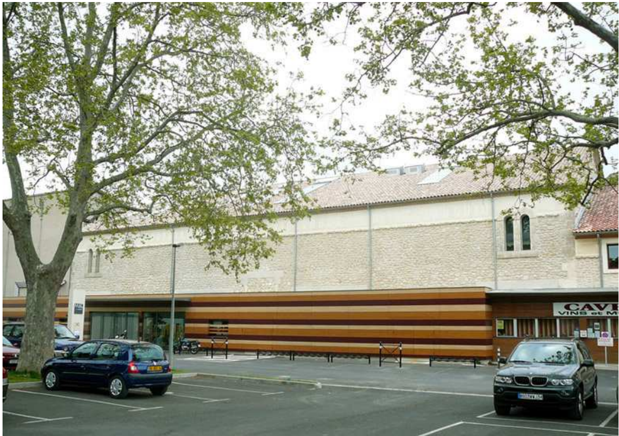
photo 12 façade de la maison de jeunesse 23
