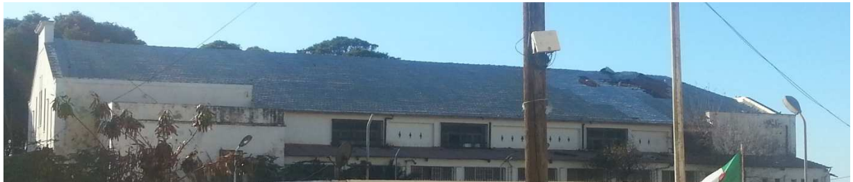
photo 15 le toit de la cave coopérative de la cave de Cherchell
