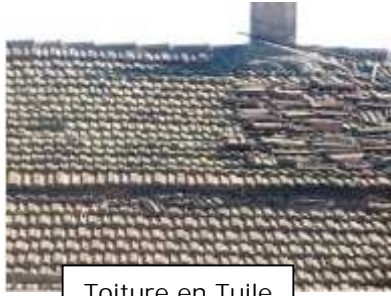
Toiture en Tuile
