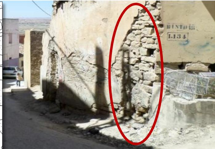
Fig 78 : Mur porteur en moellon. Source Personnelle
