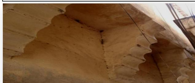
Fig 31 : Les encorbellements du Kbou, Source
