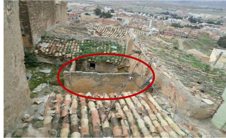
Fig 79 : Mur de séparation en brique pleine. Source : Sara BENAICHA
