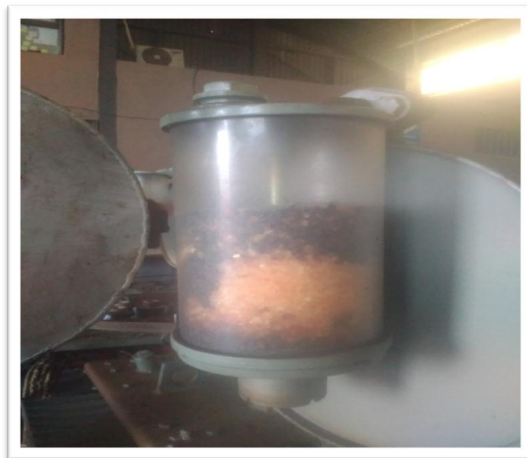
Figure 1.2 : voyant pour détecter l'état d'huile.
