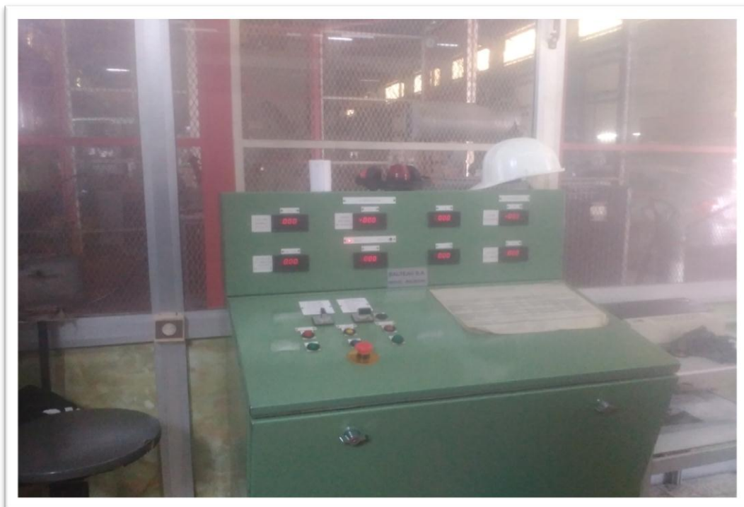
Figure 1.6 : la sale des tests des transformateurs
