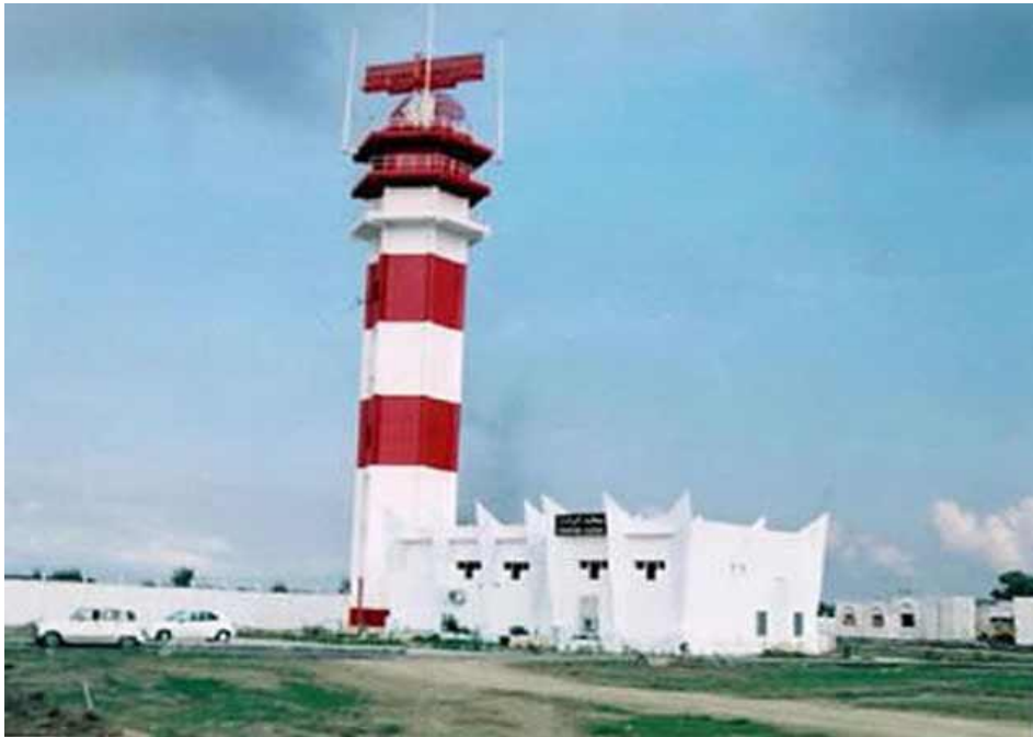
Figure II .4 : Station Radar primaire/secondaire à Oeud Smar (140 km de portée)
