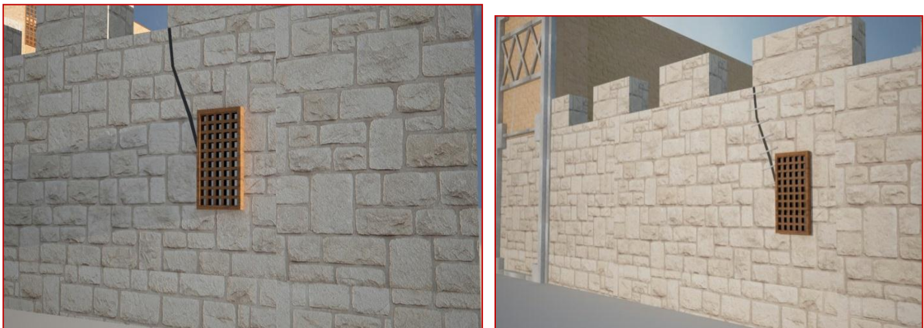
Figure 145 : réparation de la fissure par des agrafes Source : Approche proposée par l'auteur et Dr DJEBRI Simulation 3D réalisée par l'auteur
