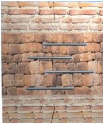
Figure 65 : Epingle protégée ancré dans le mur pour renforcement.
