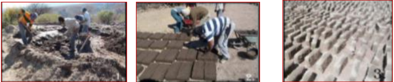
Figure 37:préparation et confection de l'adobe pour la construction
