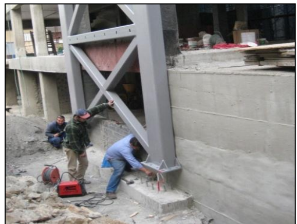
Figure 137: Fixation des panneaux sur des fondations indépendantes
