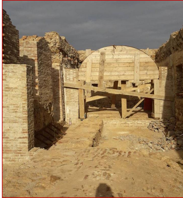
Figure 122: la salle de l'étage
