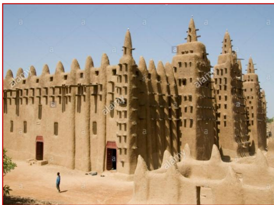
Figure 38: exemple d'un monument en adobe
