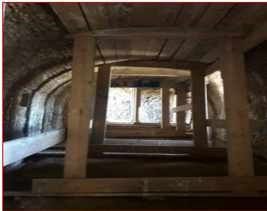
Figure 106: une photo actuelle de La rampe menant à l'étage Source photo prise par l'auteur, aout 2018
