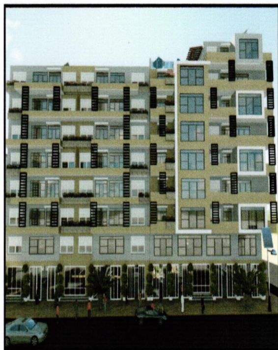
Fig3.29 la façade principale de projet Source : d'auteur 2016
