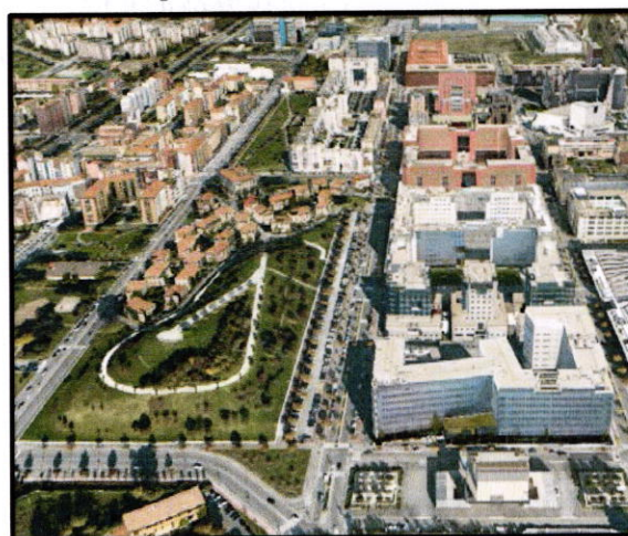
Fig2.5 Vue aérienne du site Source : empirismoereticico.it
