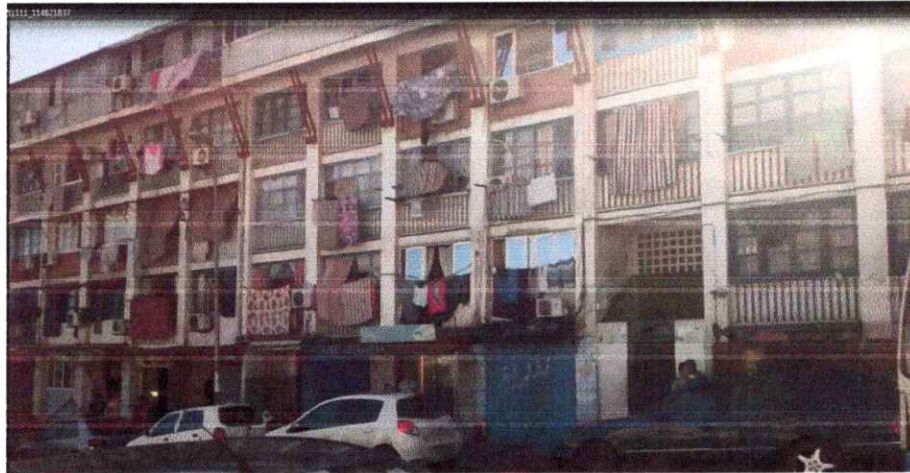
Fig. 3.44 extrait de la façade du bâtiment courbe
