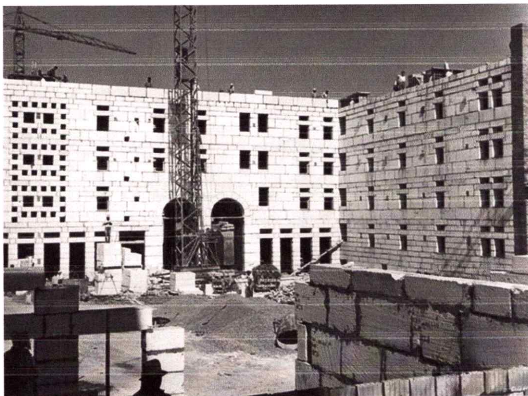
Fig. 3.18 appareillage de la pierre lors du chantier de Climat de France
