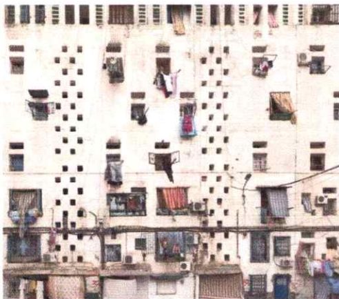
Fig. 3.45 extrait de la façade des 200 colonnes.
