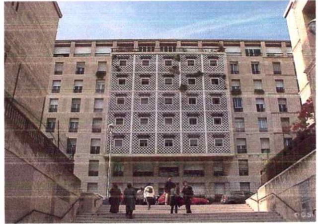
Fig 2.28 : Les escaliers monumentaux
