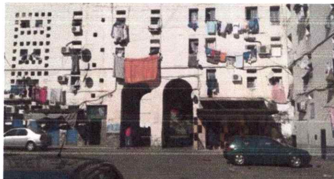
Fig. 3.31 façades du bâtiment à cour de la partie haute
