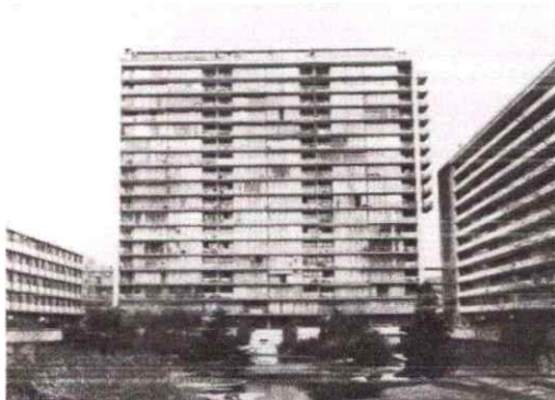
Fig.2.43 : Vue générale de la cité de la Muette à Drancy (France), E. Beaudouin architecte, 1931-1934.
