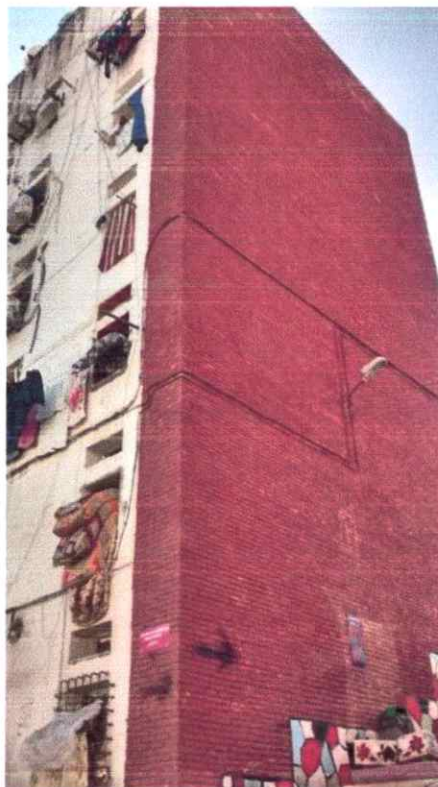
Fig. 3.19 mur de soutènement en brique d'une façade latérale de la partie haute.
