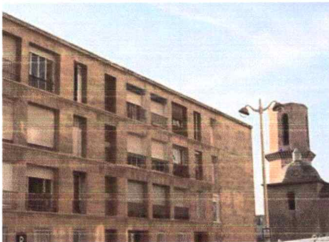
Fig 2.25 : L'appareillage de la pierre
