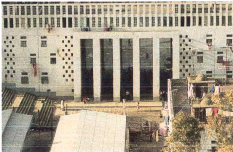
Fig. 3.40 façade extérieure des 200 colonnes
