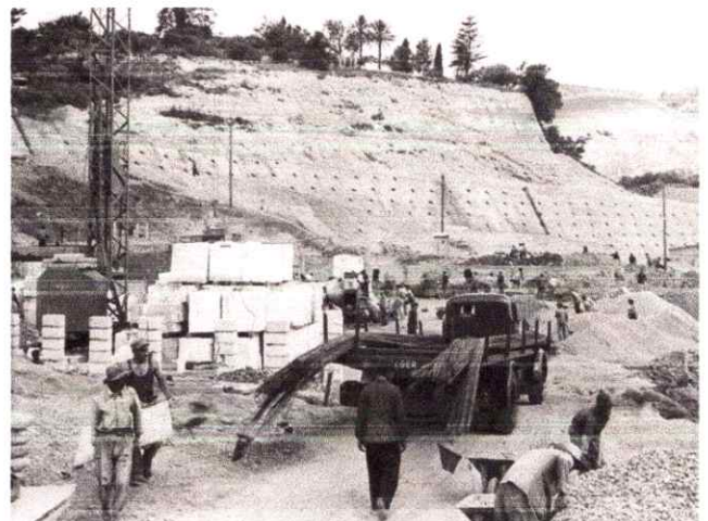
Fig. 3.3 photo du chantier lors des travaux de construction de climat de France
