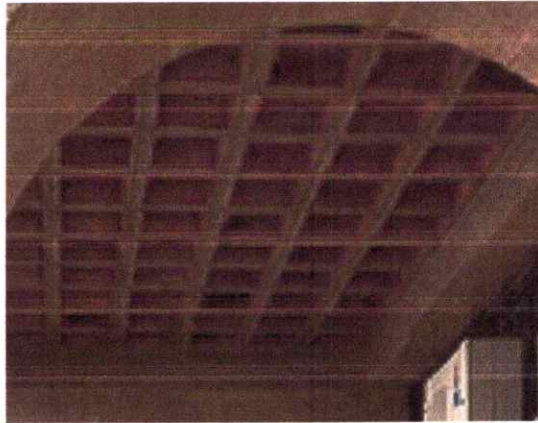
Fig. 4.19 plancher caisson à sidi frej Source : google.com
