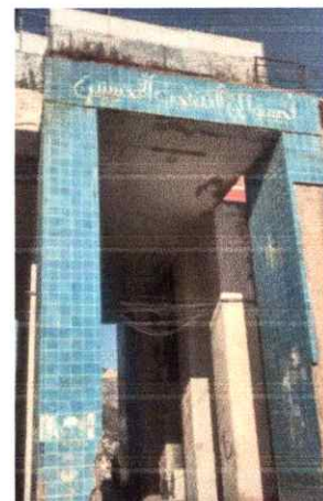
Fig. 3.41 entrée principale des 200 colonnes
