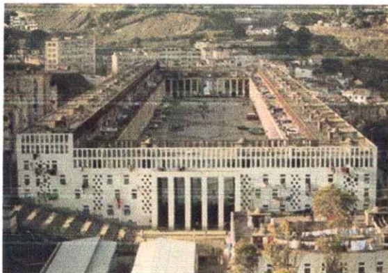
Fig. 3.26 façade ext des 200 colonnes
