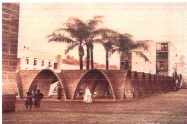
Fig : 2.42 :Vue sue les voutes, quartier confort normal Diar El Mahçoul (Algérie), F.Pouillon architecte, 1954. Source : ibidem fig 2.33 p 33
