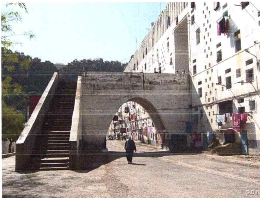
Fig. 3.48 arc paraboliques dans la partie intermédiaire
