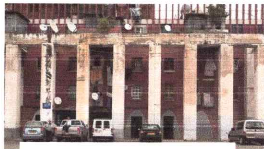
Fig. 3.28 extrait de la façade intérieure des 200 colonnes.
