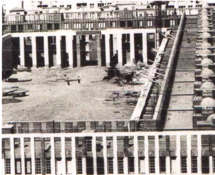
Fig. 3.39 vue aérienne sur les 200 colonnes montrant les coupoles sur le toit
