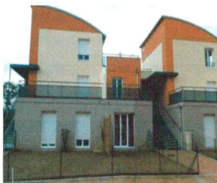
Place Diawara, Longvic (21), 6 logements semi collectif
