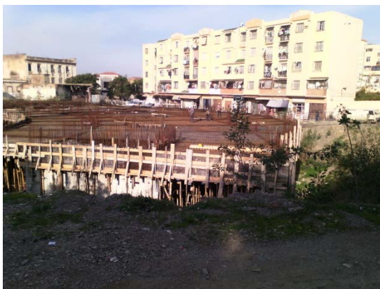
Figure 43 : photos prises par l'auteur sur le projet l'infrastructure culturelle en cours – Bécourt (Dec 2015)
