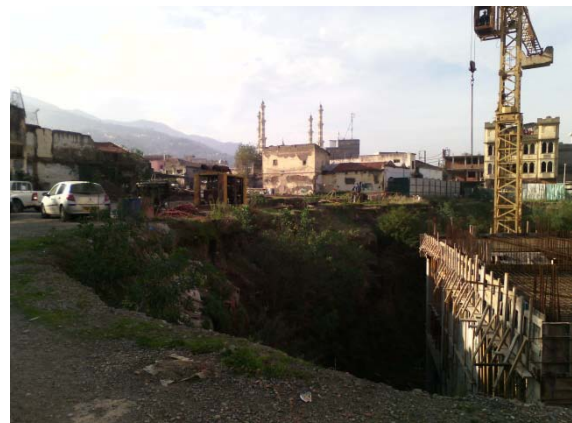
Figure 44 : photos prises par l'auteur sur le reste du terrain démolli à Bécourt (Dec 2015)
