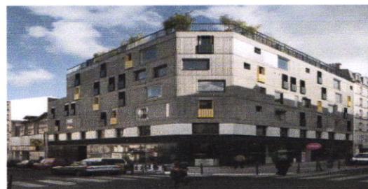
Fig. 49:Façade de l'immeuble de logement, rue Doudeville, Paris Source :photo prise de google image
