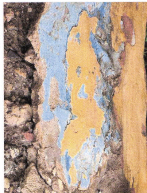
Revêtement au mortier de chaux
