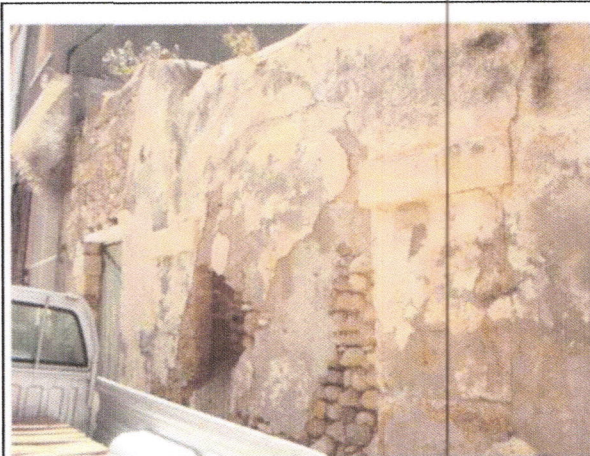
Mur en moellon et pierres de taille
