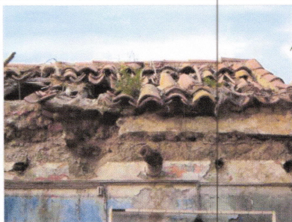
Toiture en tuiles
