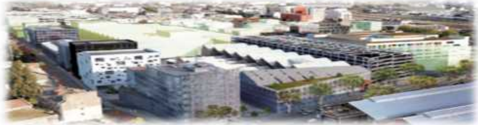
Figure 28 : Photo de la plaquette de la Samoa, Ile de Nantes
