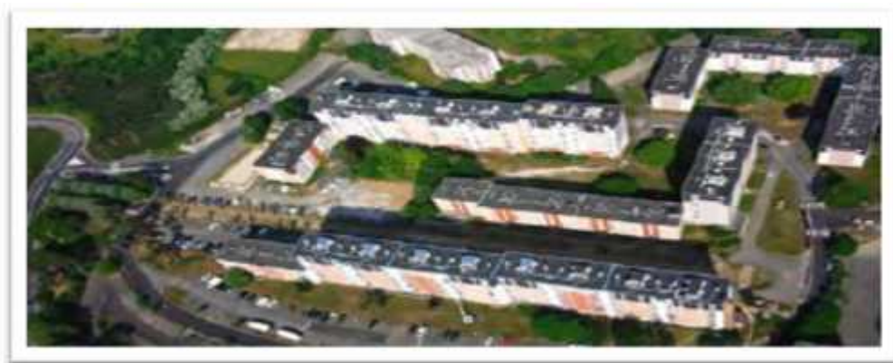
Figure 43 : L'état du quartier avant l'intervention
