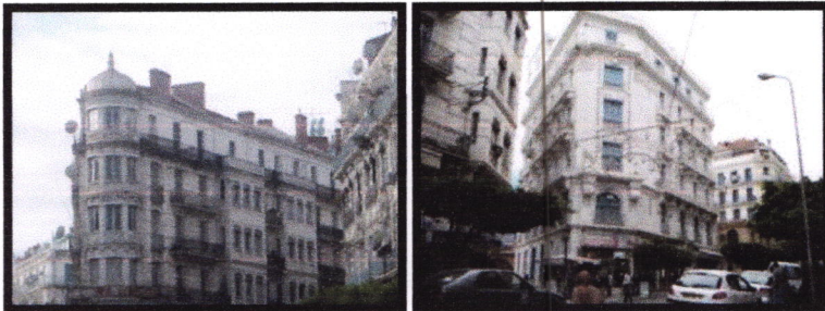
Traitement d'angle de l'immeubles du quartier d'Isly Source : prise par l'auteur
