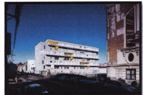
Figure 2.36 : photo générale du projet
