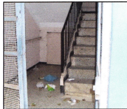
Figure 1.14 : accès au logement
