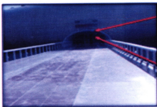
Figure 89 : vue d'une rampe d'entrée du public
