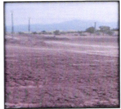
Figure 12: : Les travaux d'Autoroute Est-ouest *source : jijel.dz/jijel/index
