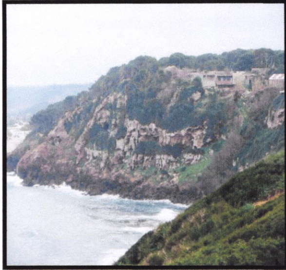
Fig N°159: construction sur la falaise qui ne respecte pas le PAC
