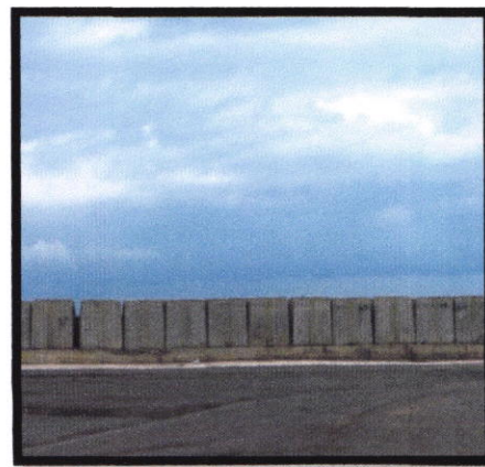
Fig N°149: le port après le dernier aménagement
