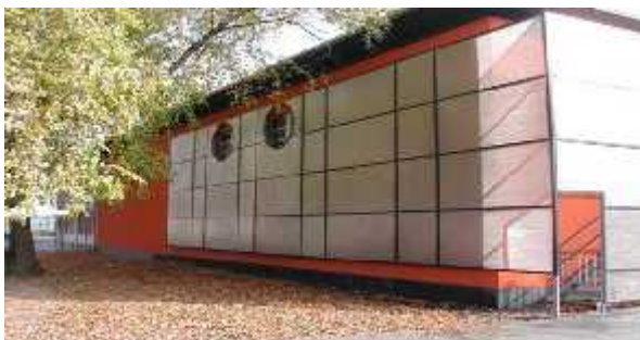
Image 1 : Protection des façades
