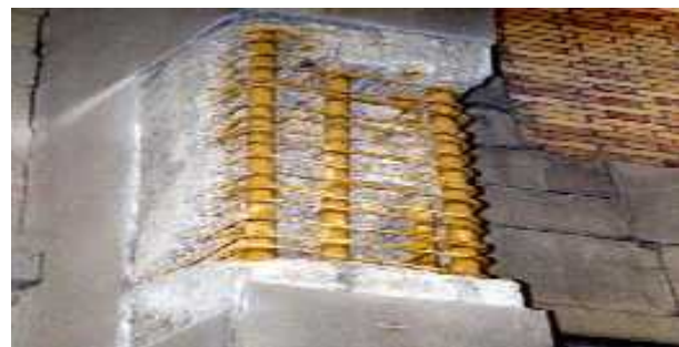
Image 2 : Protection des armatures
