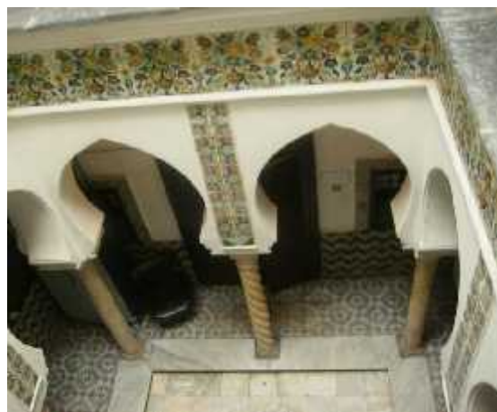
Image4 : Vue d'intérieur sur le patio d'une maison (direction de l'architecture)
