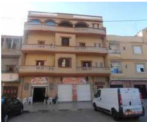
Image 03 : construction réalisée après l'indépendance à Ain El Turk (4niveaux avec des garages destinés aux commerces) Source : https://static-house.dz
