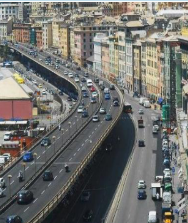
FIGURE 53 : EXEMPLE D'UN RÉSEAU MÉCANIQUE SURÉLEVÉ
