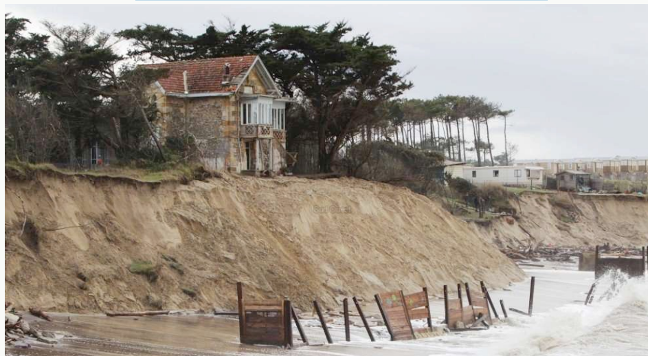
FIGURE 13 : EXEMPLE D'UNE ÉROSION CÔTIÈRE
