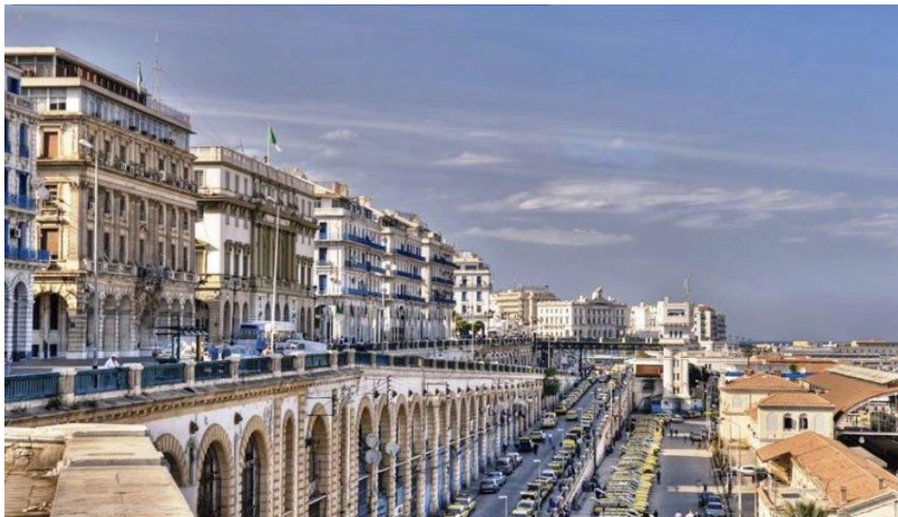
Figure 50: Alger actuellement ; séparation physique forte entre ville et port, un clivage ville/port qui persiste. Source : cours 05 typologie urbaine Master 1 ; Auteur : Dr B.K. Aouissi
