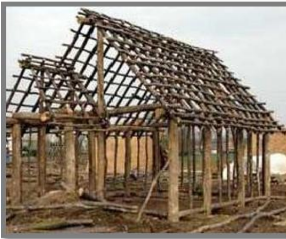
Figure 3: Structure et charpente en bois.
