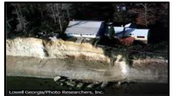
Figure 34: montre une chute de pierre
