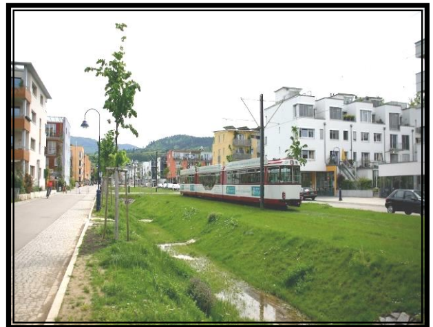
Image 08 : Retenu des eaux de pluie
