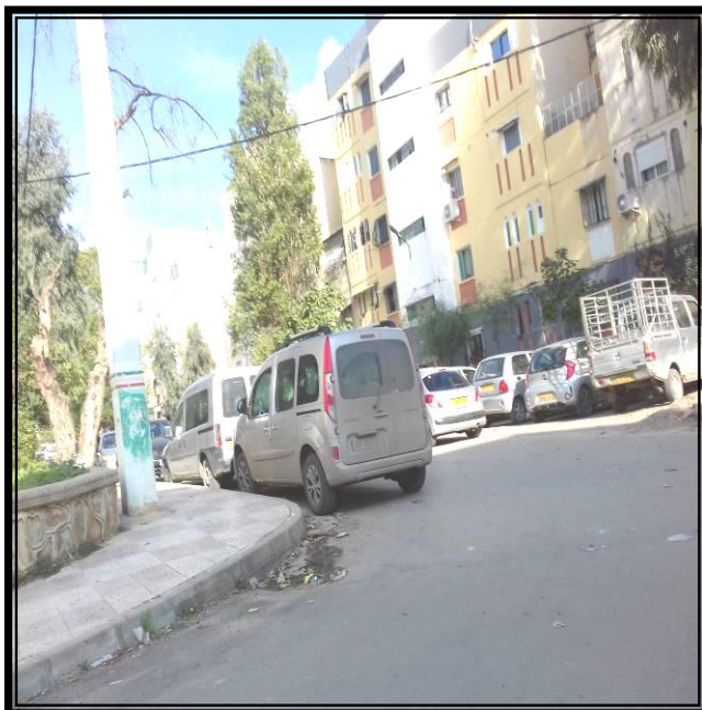
Photo 03 : vue intérieure du quartier (Stationnement devant les bâtiments et sur les voies)
