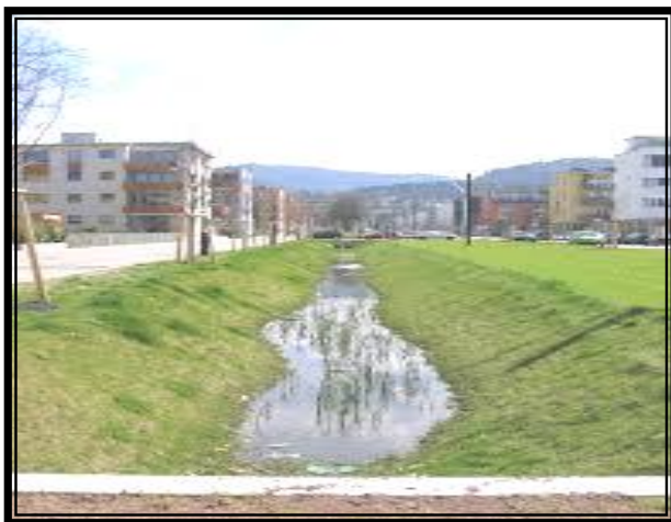
Image 07 : Retenu des eaux de pluie
