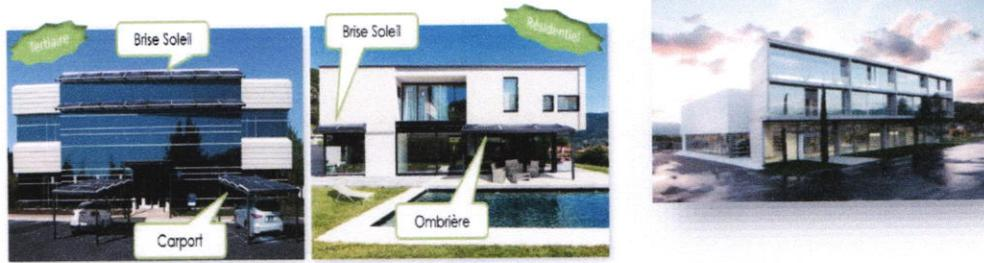
Figure 10 : brises soleil photovoltaïques et façade en baie vitrée
