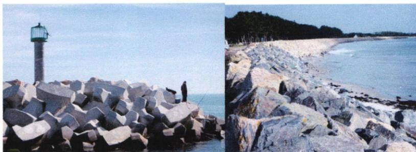
Figure 27 : enrochement artificiel et naturel
