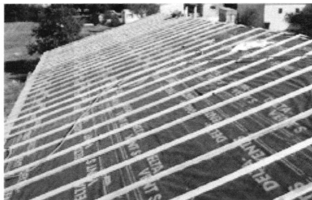
Figure (I.19): Écran souple de sous-toiture constitué d'une feuille plane lisse en polypropylène perméable à la vapeur d'eau et de deux non-tissés en polypropylène.
