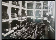
immeuble du bon marché place Bugeaud 1920-1921
