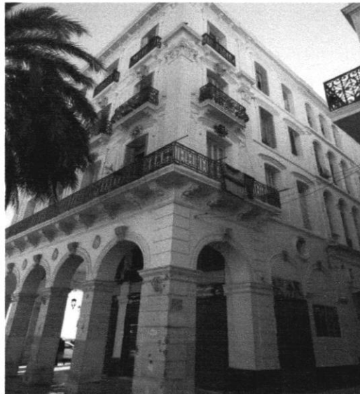
Figure 17. Bâtiment style néoclassique 1er phase
