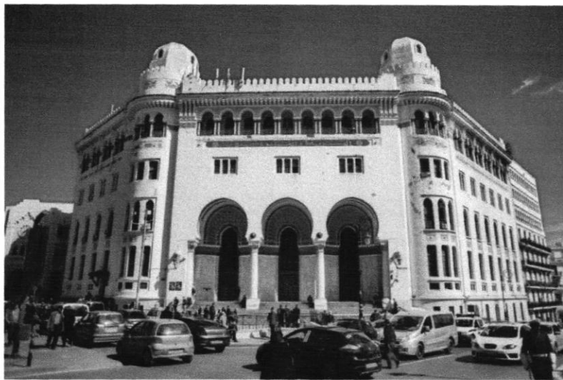
Figure 20. Façade style néo-mauresque (la Grande Poste Alger)
