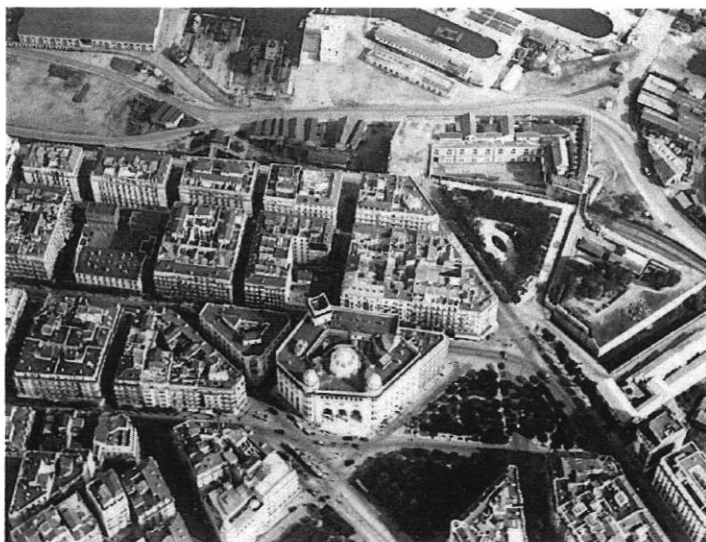
Figure 15. Boulevard la ferrière (actuellement Khemisti)
