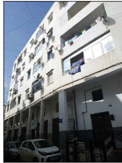
Bâti bon état
