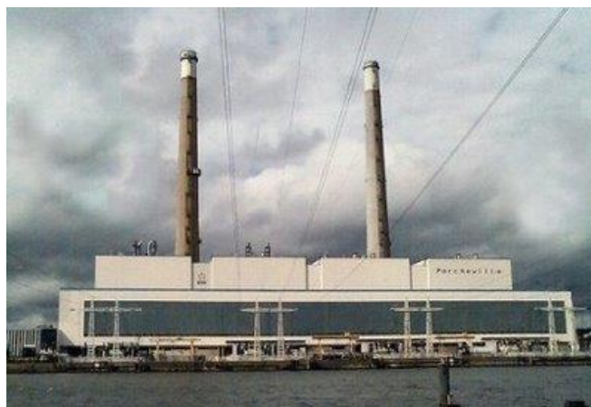
Figure 1-2 : Centrale thermique à gaz
