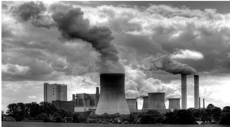
Figure 1-4 : Centrale thermique à Turbine à vapeur
