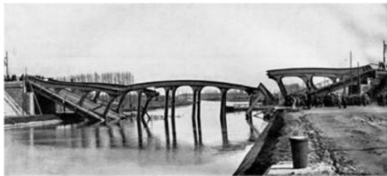
Figure 2.1 : Le pont Hasselt après sa rupture en Mars 1938 [11]
