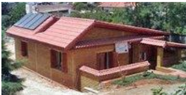
Fig. 43. Façades de l'habitation, (Source maison pilote CNERIB).
