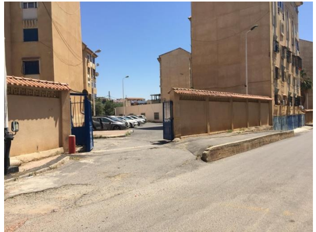
Fig. 18. Stationnement trop proche des bâtisses, (Source éditée par les auteurs).
