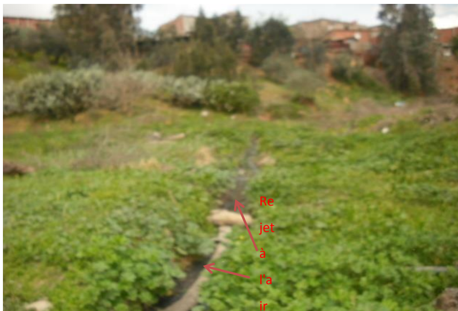
Figure III.7 : Un rejet à l'air libre du quartier 83 constructions
