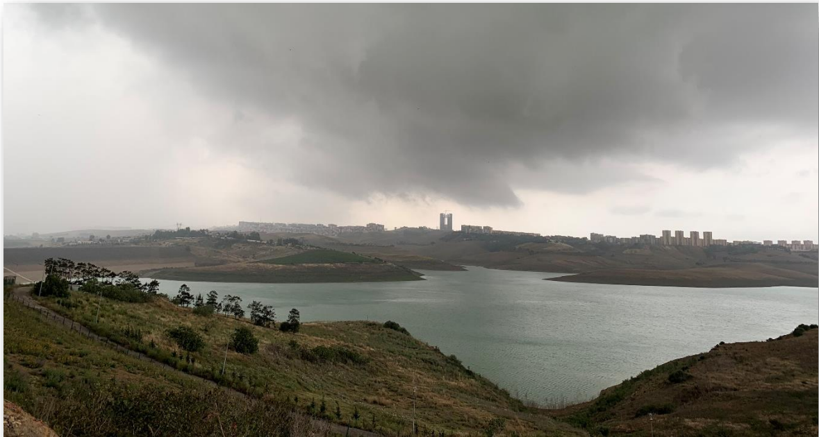
Figure 3.7 : Vue général de Barrage de DOUÈRA
