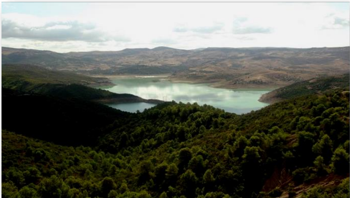
Figure 3.6 : Vue général de Barrage de BOUROUMI
