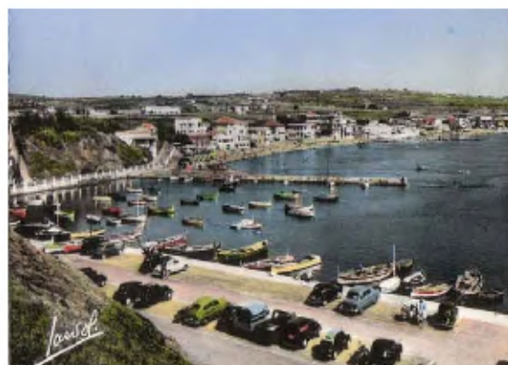
b : Vue sur la façade maritime portuaire
