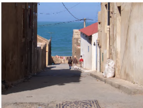
a : Blocage des ouvertures maritimes transversales du centre ville
