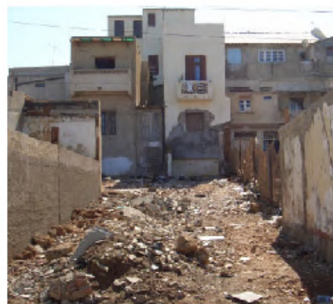
d : Dégradation de l'environnement des constructions au bord de mer
