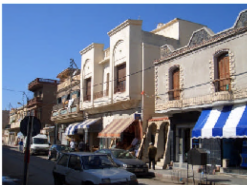
a : Densification des parcelles urbaines dans le centre ville
