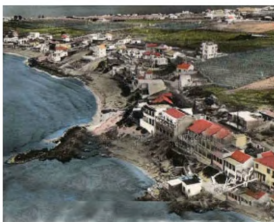
C : Vue sur les résidences balnéaire coté façade maritime ouest
