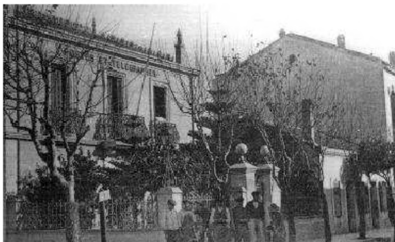
Figure 4.2.2.1: Guyot ville : vue sur les Villas
