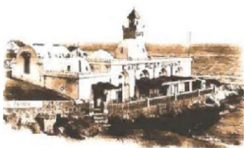
Figure 4.2.2. i: Guyot ville : Le Casino Source : http://alger.roi.fr/Alger/guyotville/
