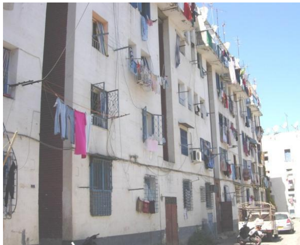
Vue sur les ouvertures, Bâtiment 13, cité du "Climat de France" (Algérie), F.Pouillon architecte.
