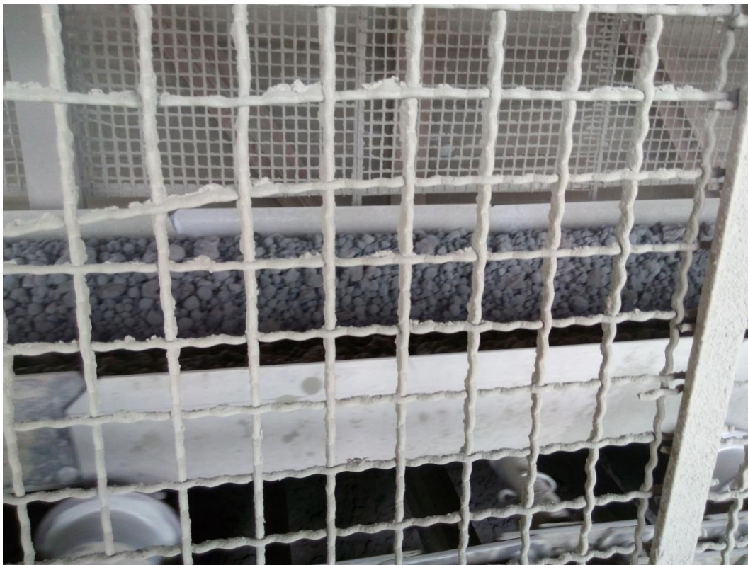
Figure26:Chaine Tablier T15(autre façade)
