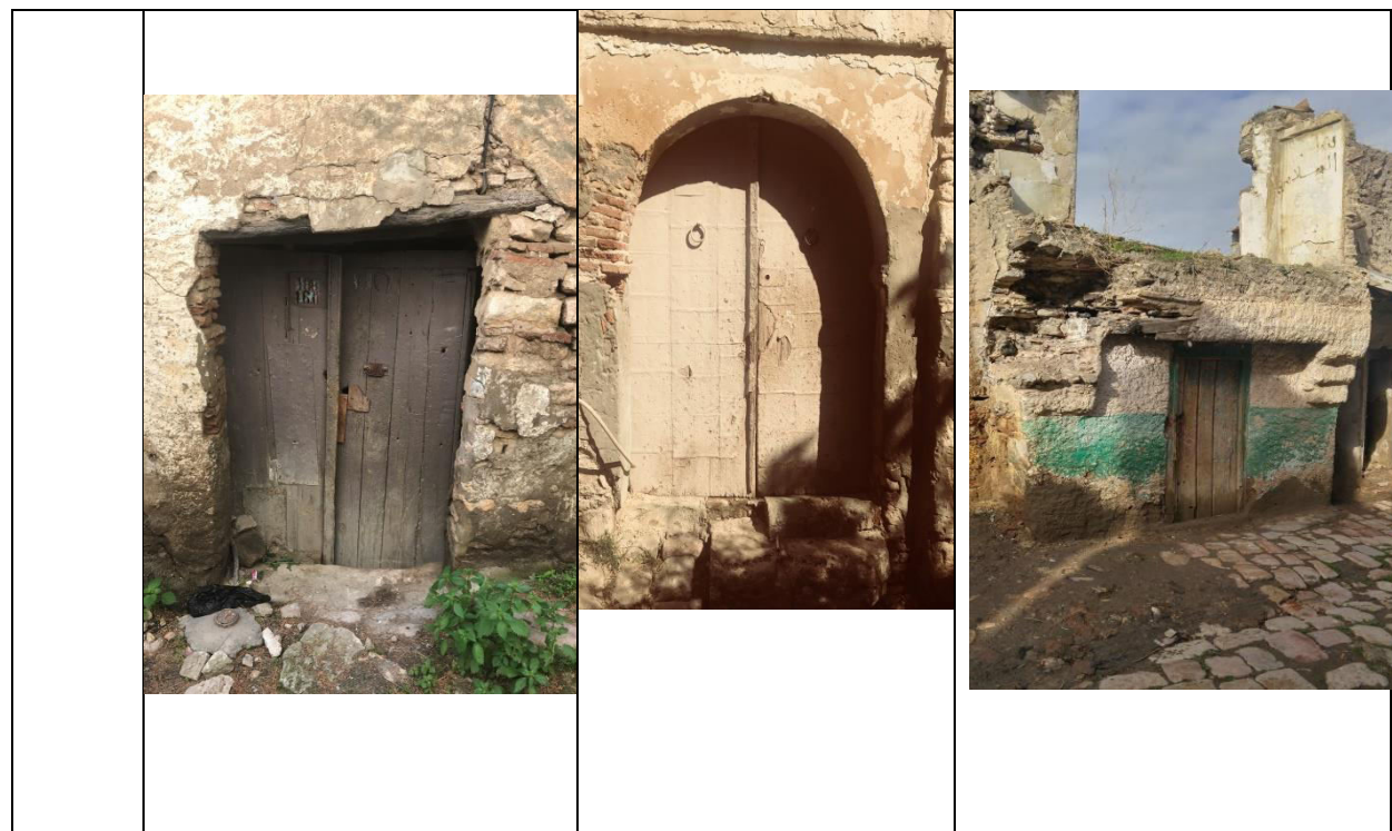
Figure 60: photos des portes, Mila, Source : auteur 2018
