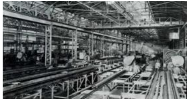
Fig. 56 : Vue partielle des Ateliers Durafour
