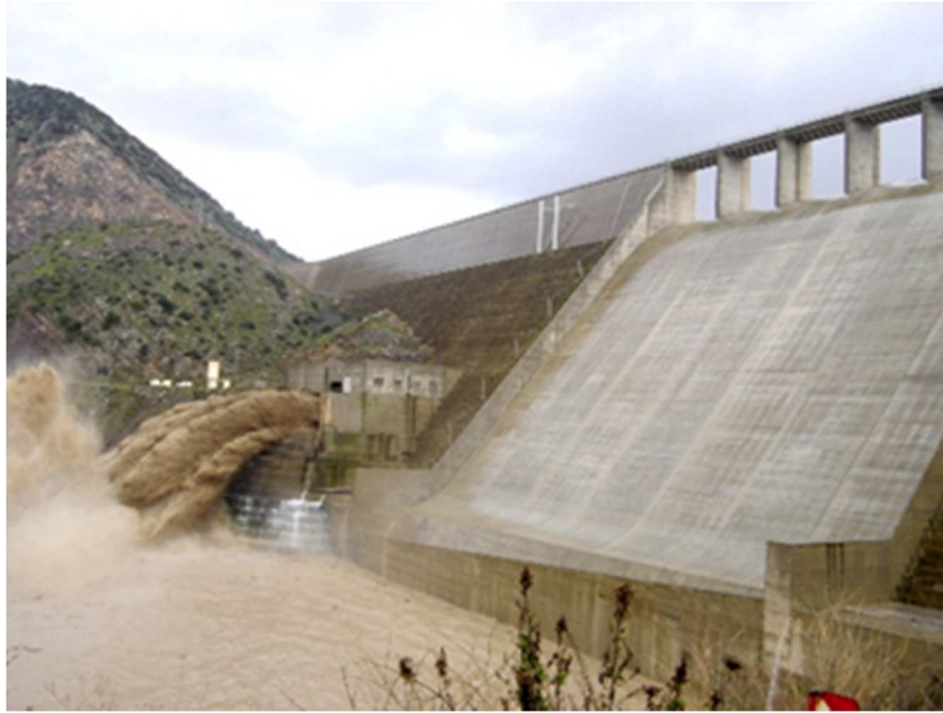
Figure.3.20. vidange de fond de barrage Beni Haroun (données ANBT).
