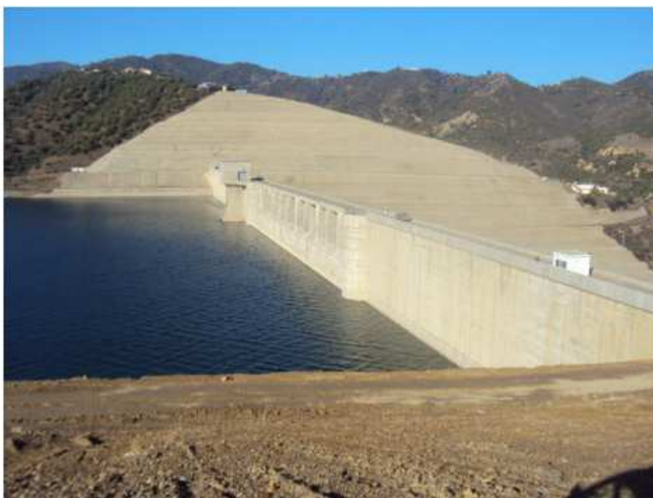
Figure.2.4.la retenue du barrage de koudiat Acerdoune (donnée ANBT).
