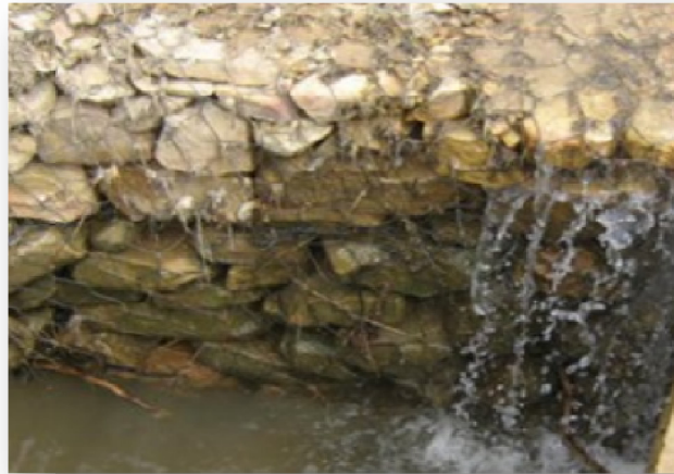
Photo III.2: Seuils de sédimentation en Gabions et en pierres sèches réalisés dans le bassin Versant du barrage BAKHADDA. (SERBAH B., 2011)
