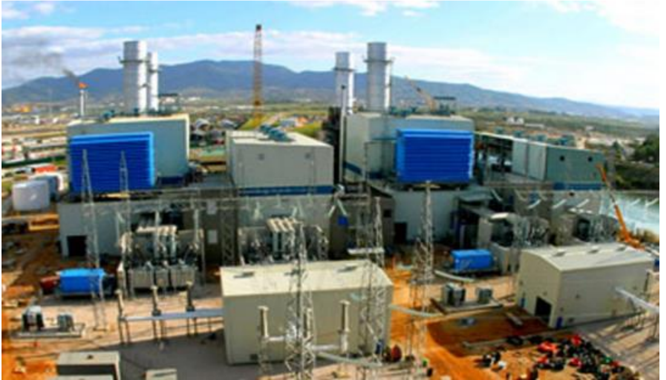
Figure 1.2. Photo réel de la centrale de Boufarik.
