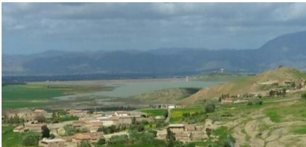
Figure n° 04 : Photo d'un vue générale du barrage de Harreza (Cliché Bettassa et Tafiani, 2018).
