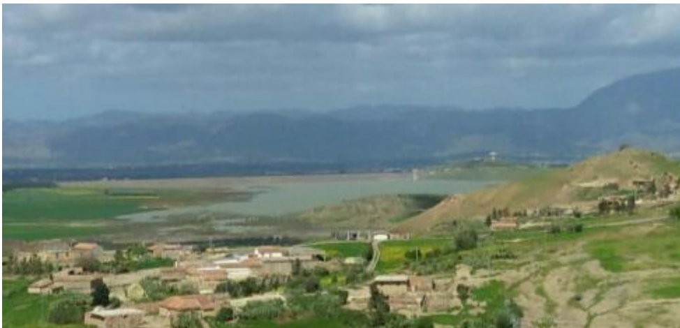
Figure n° 04 : Photo d'une vue générale du barrage de Harreza (Cliché Bettassa et Tafiani, 2018).
