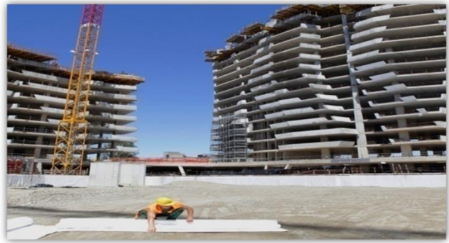
Figure 85 : Le chantier du projet
