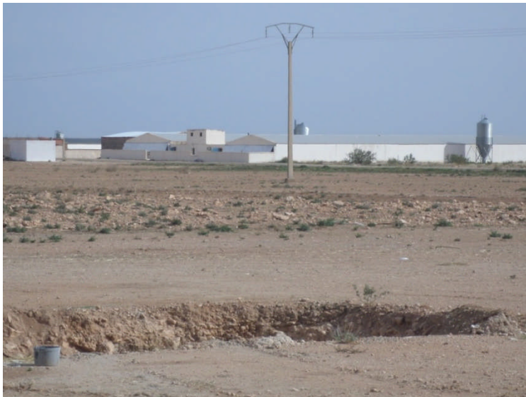
Figure11: Bâtiment de production.
