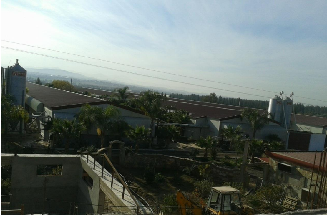
Figure 2 : Bâtiment d'élevage F.STAR
