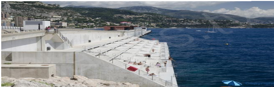
Figure30: solarium de Monaco : une digue transformée en gradin face à la mer 4
