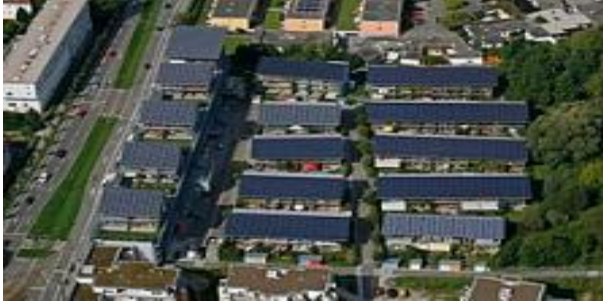
Figure77 : Installation photovoltaïque intégrée au bâti, en Allemagne 2
