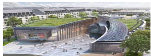
Figure61 : Façades / murs rideaux Médiathèque et cinéma à la ville littorale de Saint-Malo 5
