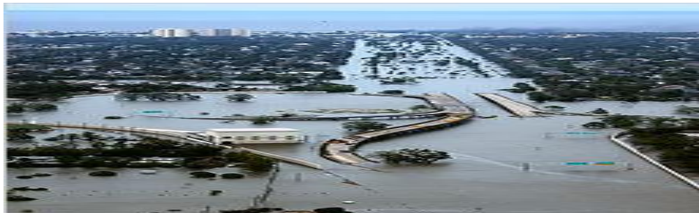
Figure 87: Submersion marine à la Nouvelle-Orléans (USA) due à l'ouragan Katerina et à la rupture des digues de protection de la ville en 2005. 4
