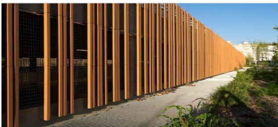
Figure58 : brise –soleil verticaux
