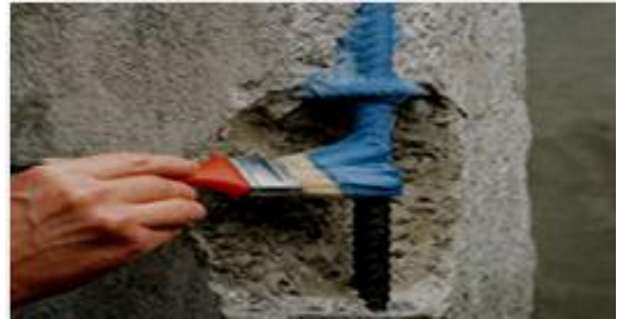
Figure 71: Peinture contre la corrosion
