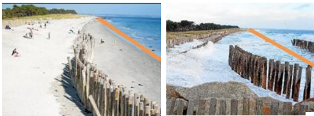
Figure 83 : Les pieux de Cleut Rouz, à Moustérlin, ont été mis en place pour «engraisser la dune» et sont destinés à protéger le rivage
