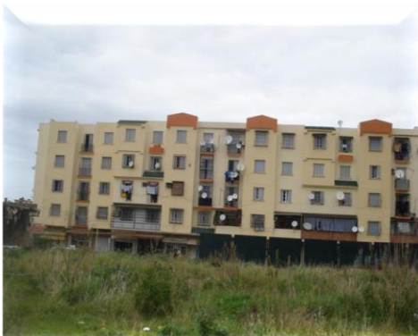
Figure 42 Bâtiment mixte au Nord
