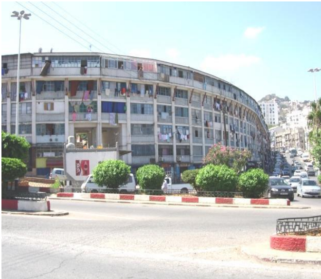
Figure22 : Vue sur les ouvertures, l'immeuble rectiligne, Cité du "Climat de France"
