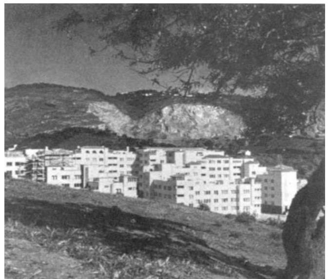
Figure 04 :Projet immobilier Boucle-Perez, vue d'ensemble, 1952
