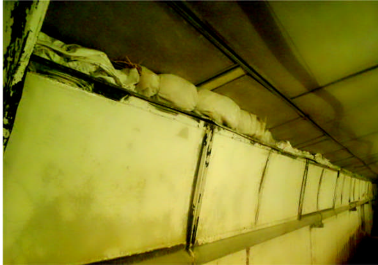
Figure 17: Fermeture des ouvertures.
