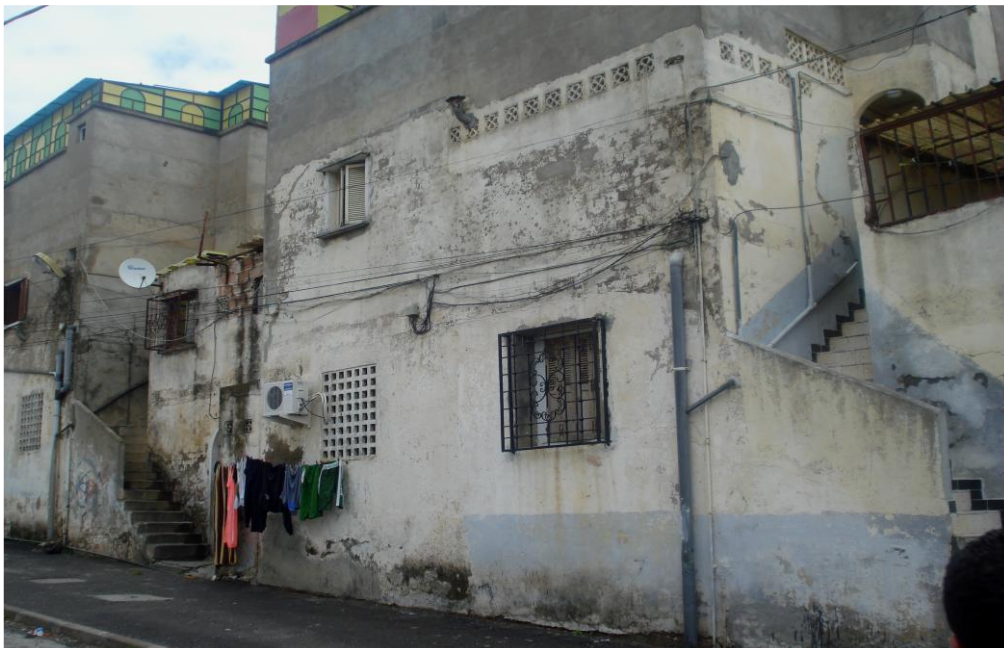
Figure.3-4 Assemblage de deux blocs de logements
