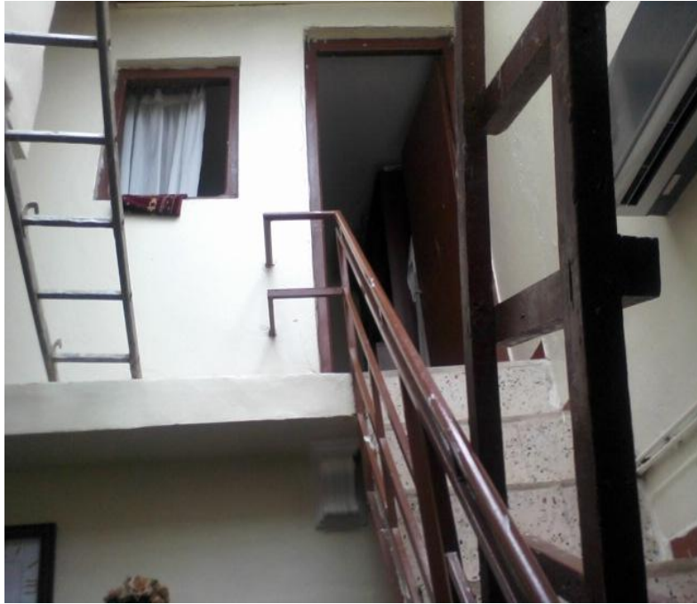
Figure .3-30 Vue sur escalier qui remplace l'échelle ( à gauche de l'image)
