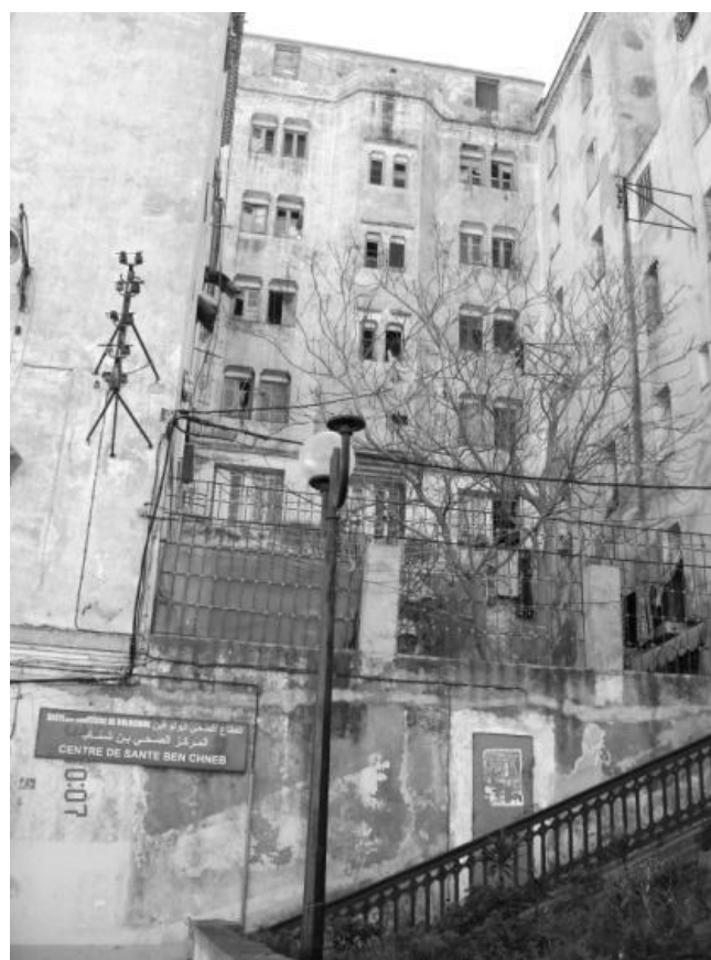
Figure. 1-14 : Façades donnant sur la boulevard Verdun.
