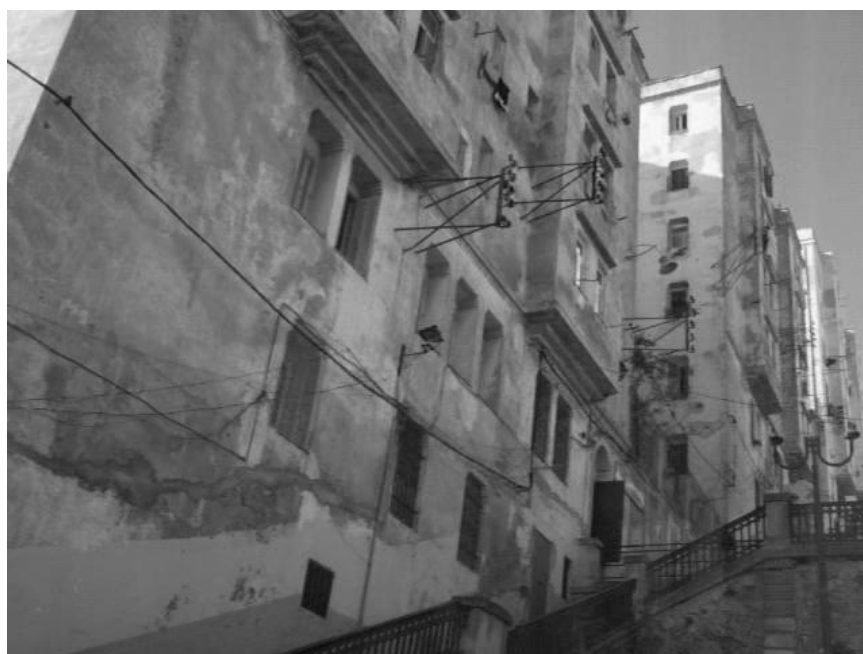
Figure. 1.12: Vue sur le groupe d'Habitations du boulevard Verdun.
