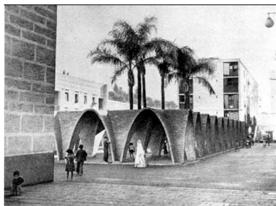
Figure.1- 24 Pouillon, Diar el-Mahçoul, vue sur la place du marché, 1957.
