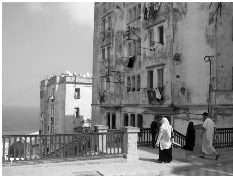
Figure. 1-13: Vue sur le groupe d'Habitations du boulevard Verdun.
