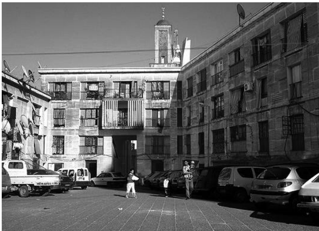
Figure 1-26 Vue sur cour de la cité Diar El Mahcoul - Pouillon
