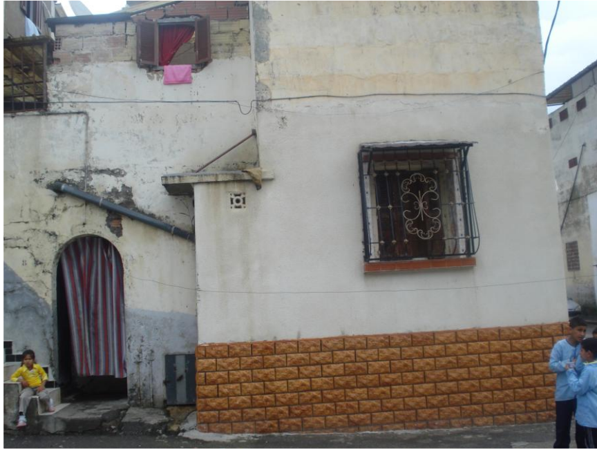
Figure.3-34 Des ouvertures vers la rue apparaissent
