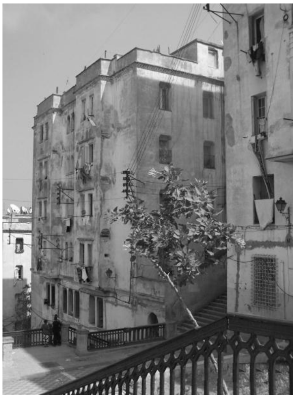
Figure.1-11 : Vue sur le groupe d'Habitations du boulevard Verdun.
