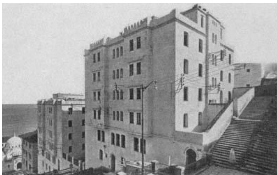
Figure 1-10 Bienvenu, logement du boulevard De Verdun, vue, 1935.
