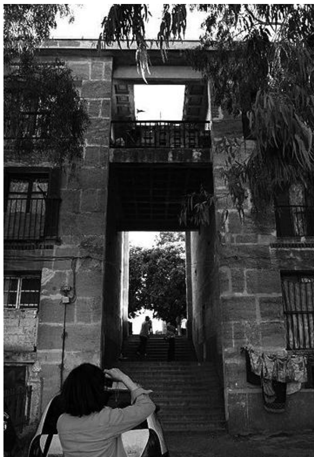
Figure 1-28 Vue sur escaliers de la cité Diar El Mahcoul - Pouillon Source : Photo prise par l'auteur
